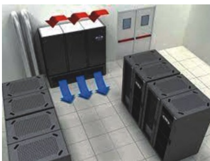
Εικόνα 5. Λύση Displacement-Frontal χωρίς ψευδοπάτωμα
